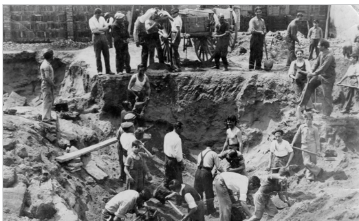
Construcció d'un refugi antiaeri al barri del Poblenou de Barcelona, 1936-1937. Manuel Centelles. Arxiu personal Alicia Bou
